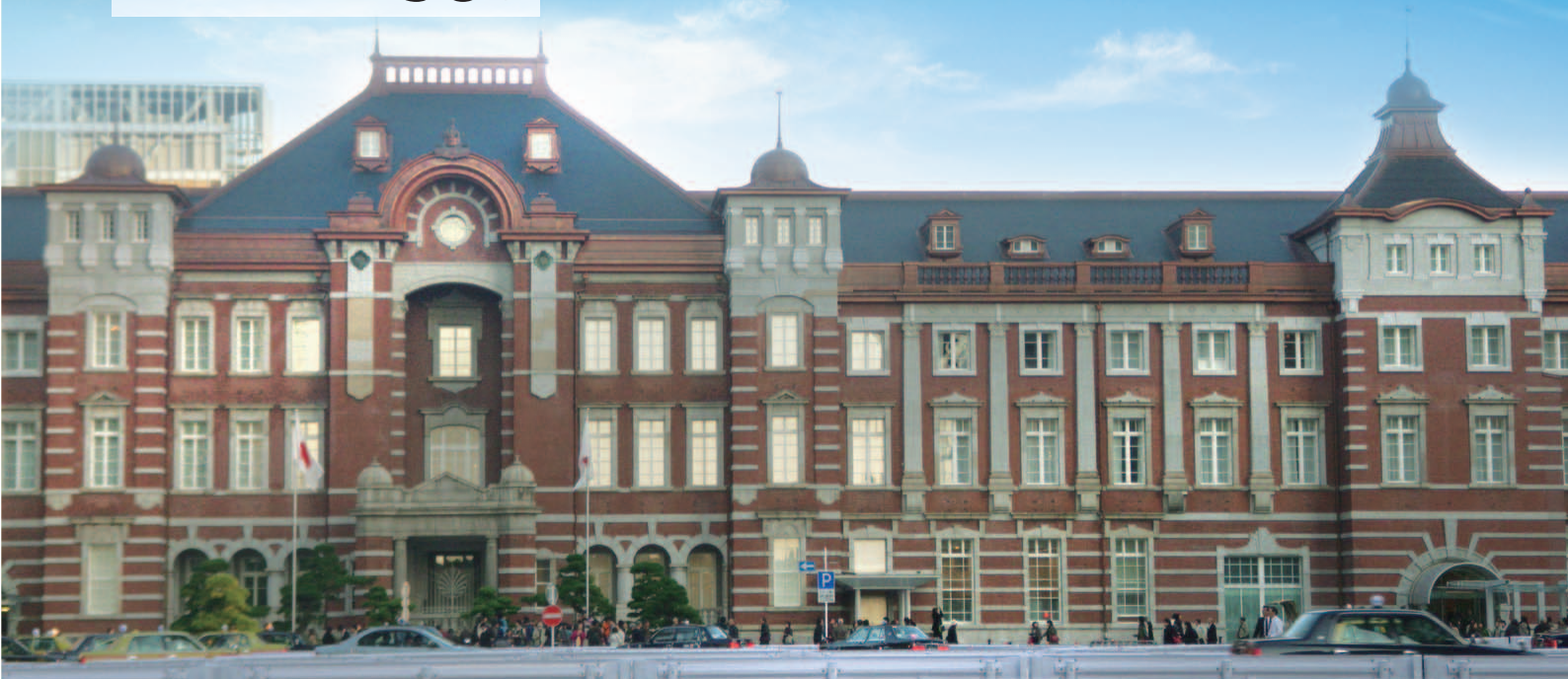
辰野金吾設計の東京駅。保存復元工事が進められ 10月1日にグランドオープン。
